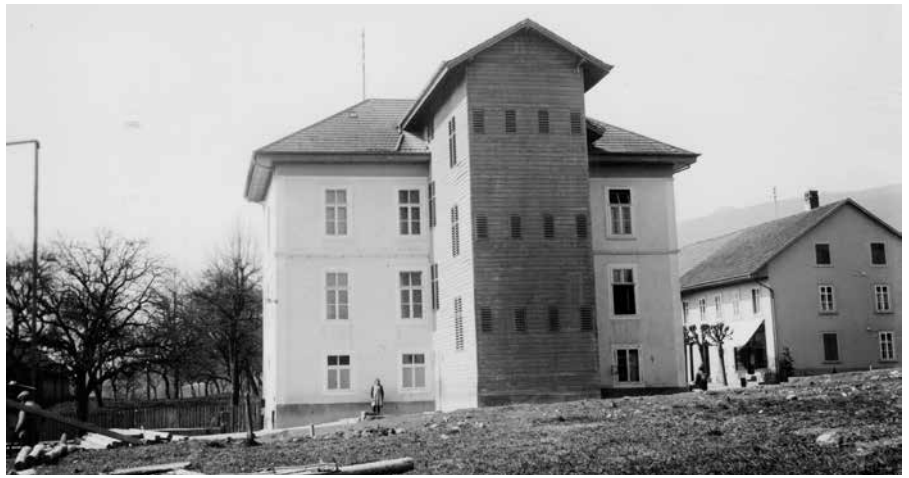
Das erste Schulhaus. Blick von Osten.
